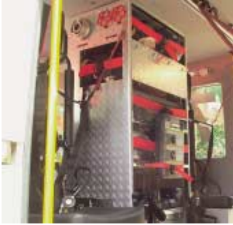
Abb. 2.1.1/1: Atemschutzüberwachungstafel im Mannschaftsraum gelagert (Foto: Cimolino)
