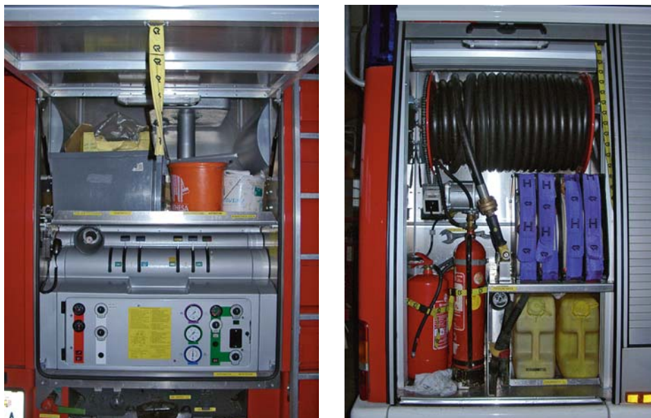
Abb. 4.9.2/1a) und b): Hochdruck-FP 1 und -Schnellangriff in einem RLF der FF Rohrbach (A) (Fotos: Springer, Rohrbach)
