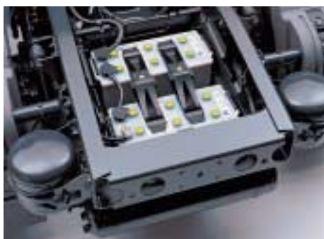
Abb. 3.3.7/2: Batterie im hinteren Bereich des Fahrzeugrahmens bei einer MB Actros Sattelzugmaschine (Foto: DaimlerChrysler)
