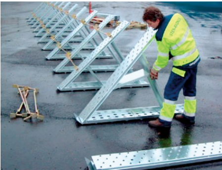
Abb. 3.1/6: Aufbau der Stützen und Montage der Abstandshalter
